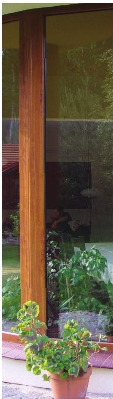
La serie PRESTIGE è un esempio dell'utilizzo sinergico delle proprietà dei profili e dei vetrocamera per creare finestre caratterizzate da una trasmittanza termica molto bassa. Grazie all'impiego nella dotazione standard del **vetro con spessore di 48 mm** siamo in grado di ottenere i migliori parametri termici per la finestra di riferimento **Uw=0,94**.
